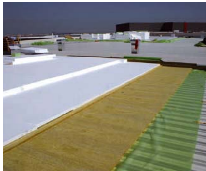
Példa az SG COMBIROOF 30M rendszer alkalmazására egy logisztikai központ tetőjének építésénél.
