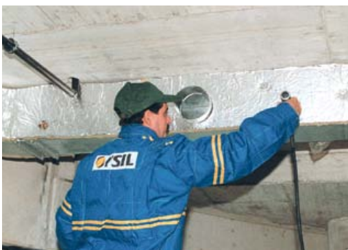
Az ORSTECH lapoknak a csatornára történő felszerelése
