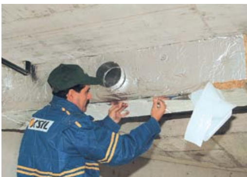
A csatlakozások és élek leragasztása
