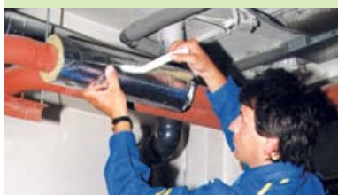
A védőréteg eltávolítása az alumínium öntapadós átfedő rétegről.
