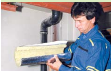
Orstech csőhéj szigetelés beszerelés előtt.
