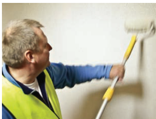
Teljes gipszkarton felületre legalább 1mm vastag simítás kerül.
