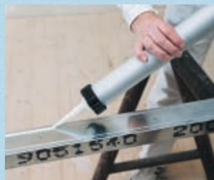
Knauf Trennwandkitt az UW profil hátoldalán
