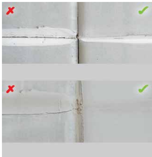
Helytelenül és helyesen megfózolt él, hézagolás után.
