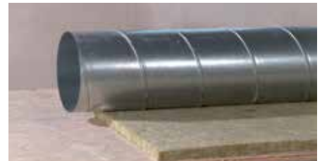
1. lépés – A szigetelés pontos méretre vágása
