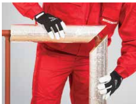
7. kép – Szigetelő elemek összeillesztése
