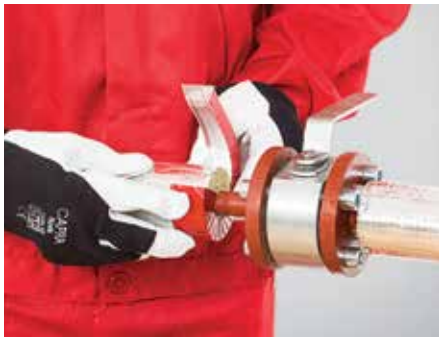
23. kép – Az egyenes szakaszok végeinek lezárása alumínium szalaggal
