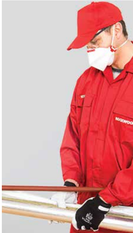
1. kép – A szigetelés felhelyezése
