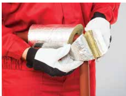
11. kép – Egy szegmens felhelyezése
