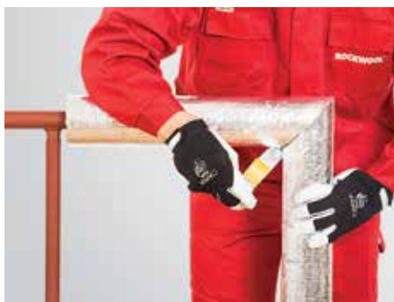
8. kép – Csatlakozások lezárása öntapadó alumínium szalaggal
