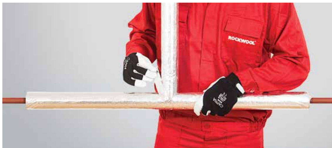
19. kép – Illesztések összeragasztása öntapadó alumínium szalaggal
