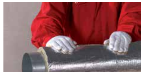
2. lépés – A szigetelés ráhajtása a csatornára
