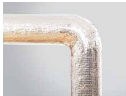
14. kép – Elkészült szigetelés PIPO ALS csőhéjjal
