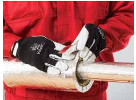
22. kép – A szigetelés lezárása alumínium szalaggal
