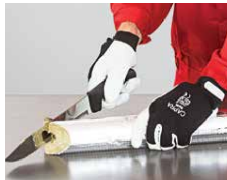
16. kép – 2x45°-os ék levágása a becsatlakozás helyén
