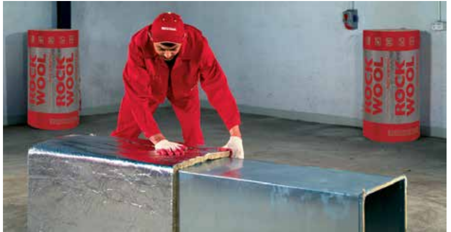
3. lépés – A szigetelés felragasztása
