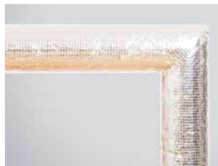
9. kép – Elkészült könyök szigetelés két elemből
